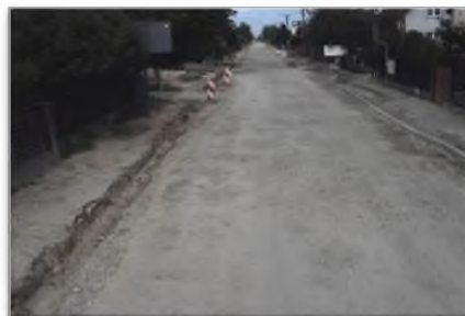
Przebudowa ulicy Siekiereckiej w Gowarzewie
