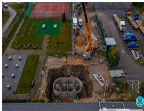
Zakończenie budowy podziemnego zbiornika retencyjnego dla wód opadowych (fot. Starostwo Powiatowe w Poznaniu)
