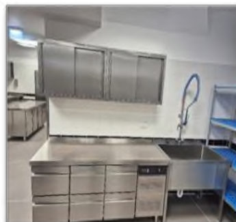
Przebudowa kuchni z pomieszczeniami pomocniczymi i zapleczem w Specjalnym Ośrodku Szkolno-Wychowawczym dla Dzieci Niewidomych w Owińskach, Plac Przemysława 9 (fot. Starostwo Powiatowe w Poznaniu)
