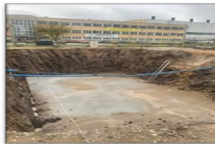
Budowa podziemnego zbiornika retencyjnego dla wód opadowych (fot. Starostwo Powiatowe w Poznaniu)
