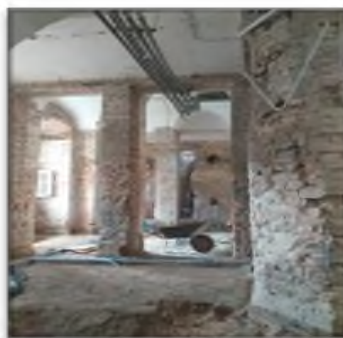
Wykonanie wentylacji mechanicznej poddasza i usunięcie zawilgocenia piwnicy zabytkowego budynku szkoły w Murowanej Goślinie (fot. Starostwo Powiatowe w Poznaniu)
