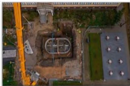
Budowa podziemnego zbiornika retencyjnego dla wód opadowych (fot. Starostwo Powiatowe w Poznaniu)
