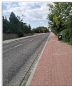
„Cicha nawierzchnia” na ulicy Siekierckiej w Gwarzewie (fot. Zarząd Dróg Powiatowych w Poznaniu)
