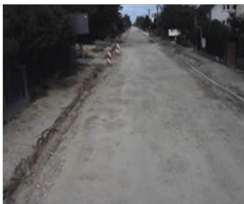
Budowa nowego przepustu i ronda w Biedrusku (fot. Zarząd Dróg Powiatowych w Poznaniu)
