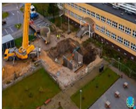
Zakończenie budowy podziemnego zbiornika retencyjnego dla wód opadowych (fot. Starostwo Powiatowe w Poznaniu)
