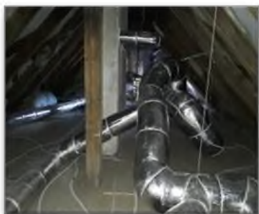
Wykonanie wentylacji mechanicznej poddasza i usunięcie zawilgocenia piwnicy zabytkowego budynku szkoły w Murowanej Goślinie (fot. Starostwo Powiatowe w Poznaniu)
